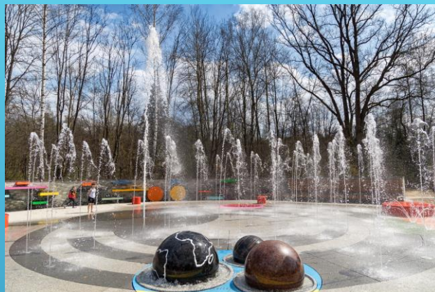
budowa Placu Wodnego i Bulwarów
