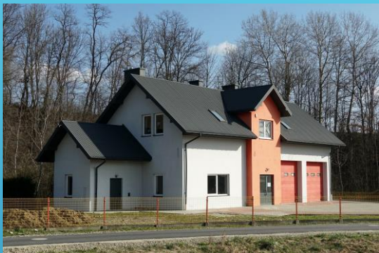
9. Budowa remizy w Gostwicy
