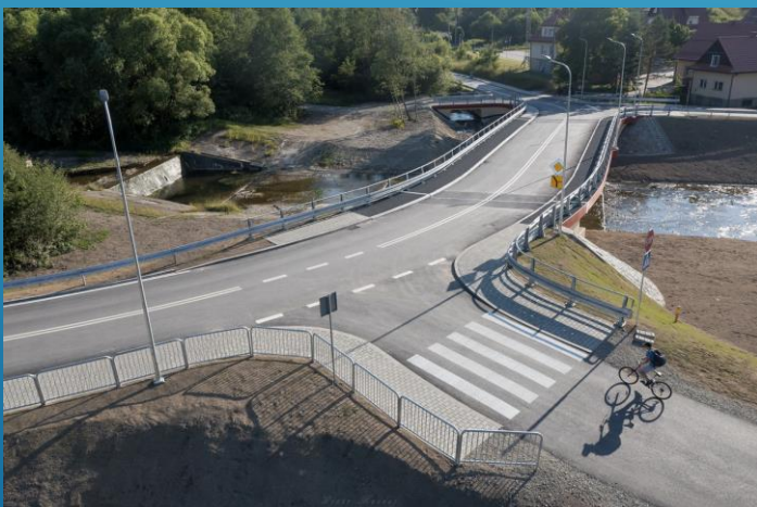
budowa mostu w ciągu drogi „Do Pocznej Wody”
