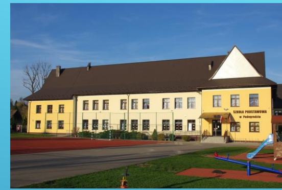
4. Termomodernizacja SP Podegrodzie
