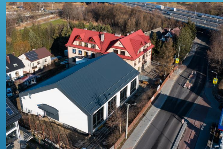
budowa sali gimnastycznej w Chabówce
