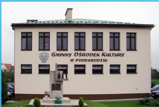
2. Gruntowny remont GOK Podegrodzie i budynku urzędu gminy
