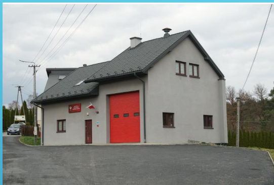
10. Budowa remizy w Długotęce-Świerkli
