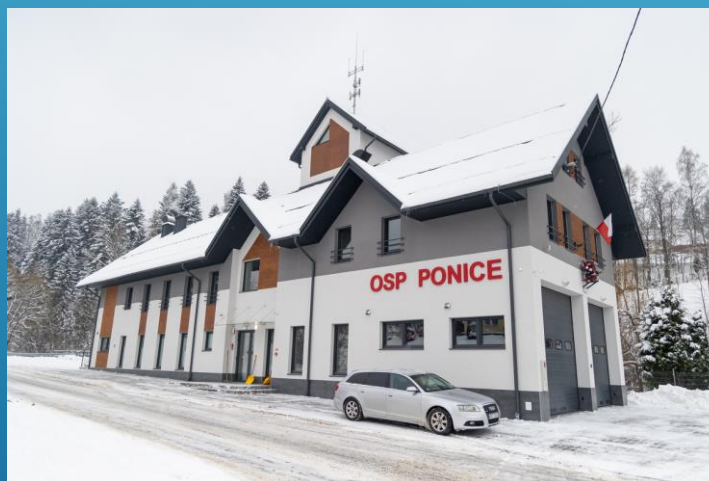
budowa od podstaw remizy w Ponicach
